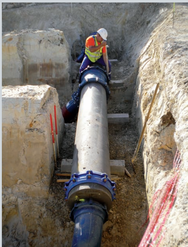
Serrage du kit express distributeur lors de l'installation du puits canadien ; un système utilisant la géothermie afin de réguler la température des locaux sans hypothéquer les ressources naturelles.
